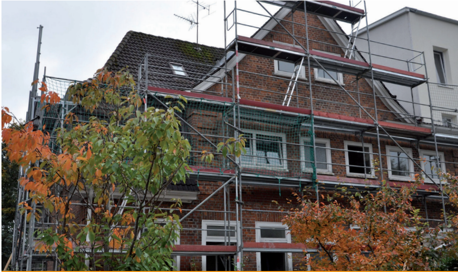
Die Umbaumaßnahmen am zukünftigen Hospiz-Haus haben begonnen
